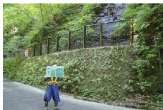
完成(国道102号:落石防護柵)
