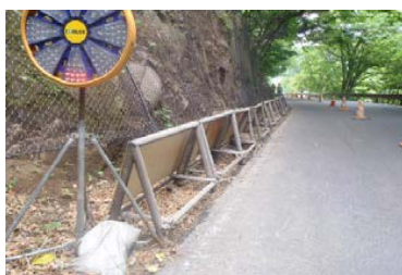
木製バリケードの設置
