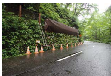
茶系シートによる養生(仮設足場)
