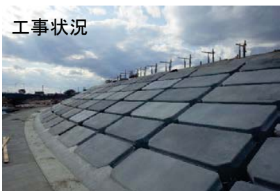
二次製品の使用 (冬期の品質確保・工程短縮)
