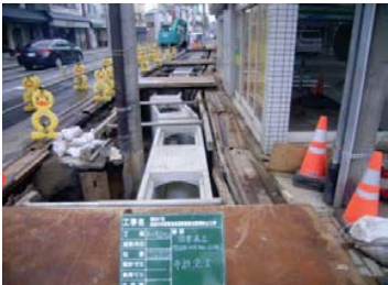
既設横断水路取壊し完了
