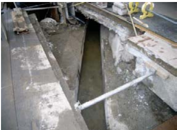
既設横断水路取壊し完了
