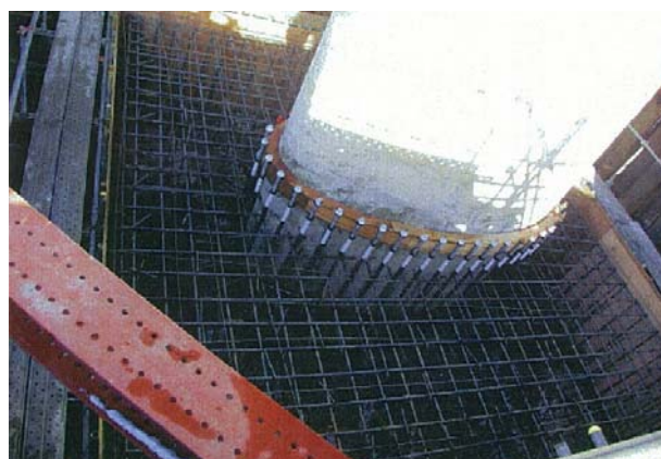
鋼板基部定着アンカー設置
