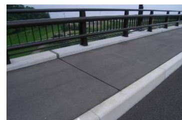
歩道部のカッター目地
