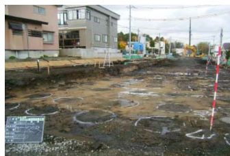
深層混合処理完成
