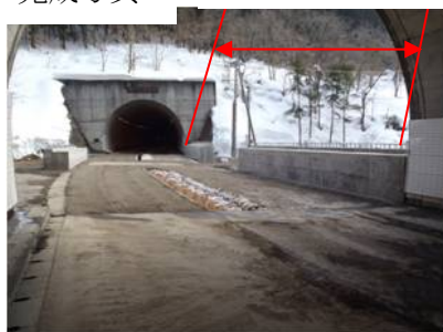
完成写真 下部工 L=40.8m
