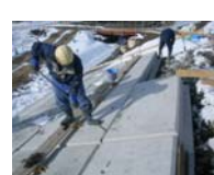
簡易脱着足場
