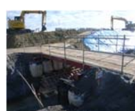
仮棧橋の設置
