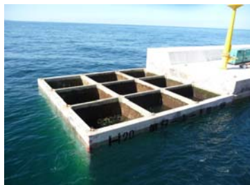
ケーソン据付完了
