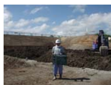
施工基面改良状況
