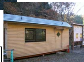
スギ間伐材使用現場事務所
