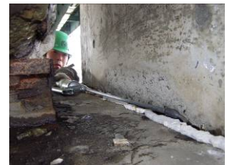
ハンドガンノズルの改造による 狭隘部のひび割れ注入
