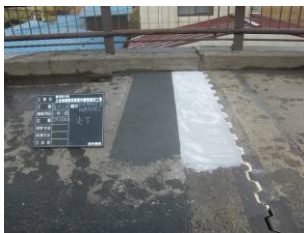
マクリ樹脂モタルによる 伸縮装置段差解消
