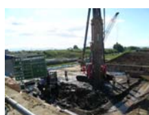
基礎杭施工状況
