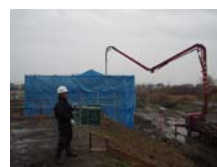
コンクリート打設状況
