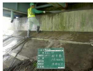
支承・橋座面清掃
