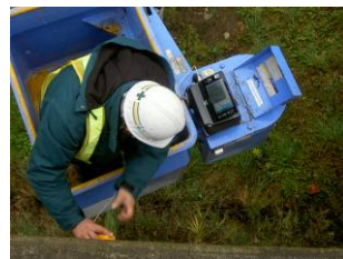
ひび割れ測定
