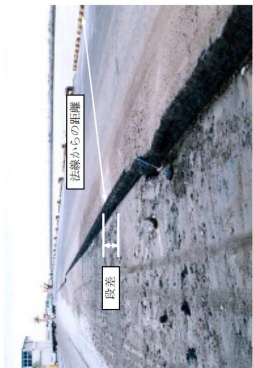
※法線（上部工海側端部）からの概ね距離を記載し、段差をコンベックス等で計測（沈下を（+）で記載）。
