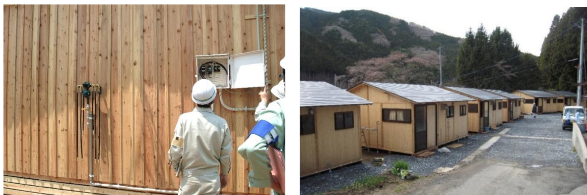
(完了検査状況)
