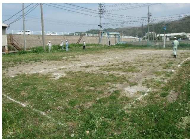
(縄張り検査状況)
