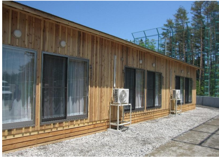
(地元建設業者による木造の住宅)
