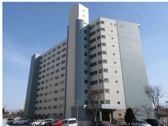
バイサイド柳川(青森市) 外壁その他改修工事
