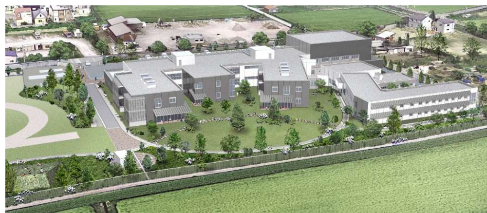
県立盲学校・青森聾学校改築工事(R6～8予定)
