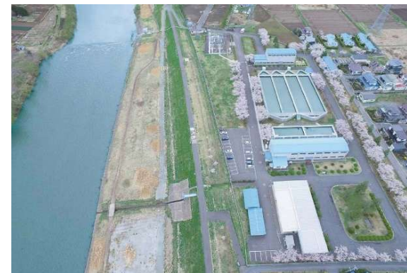
八戸工業用水道管理事務所
