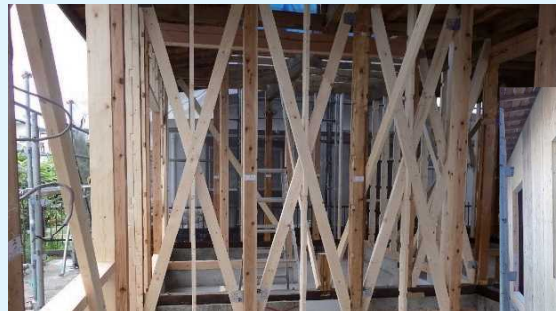
耐震補強工事
