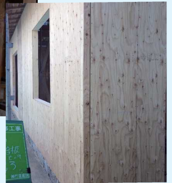
耐震補強工事
