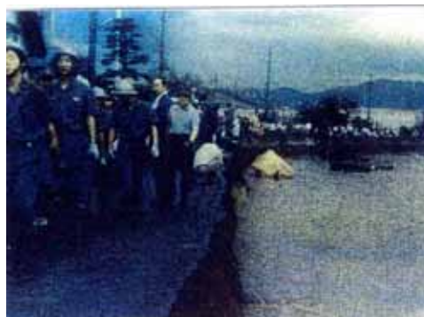
写真 - 2 S.52.8 豪雨 濁流でえぐられた青森市堤川護岸
