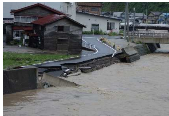
護岸の被災状況
