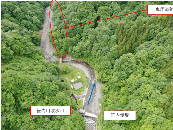
① 笹内堰堤付近
