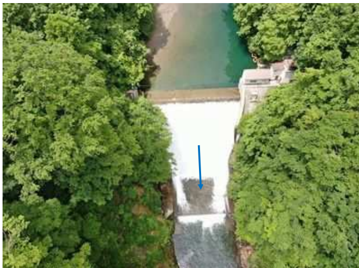
①赤石ダム（下流から）
