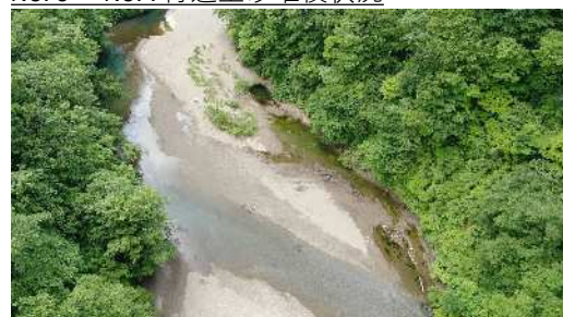
No. 6～ No. 7付近土砂堆積状況
