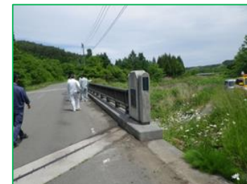
重要水防箇所等の合同巡視
