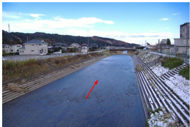
整備後（渡の葉橋～滝谷橋付近）
