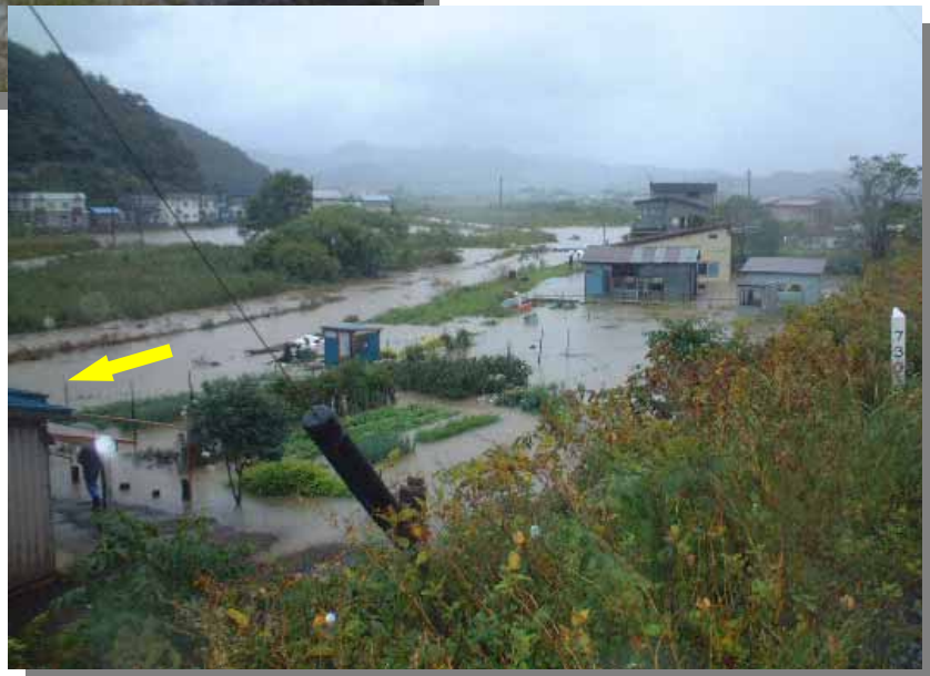
写真-1.3 平成 16 年 9 月 洪水時の状況
