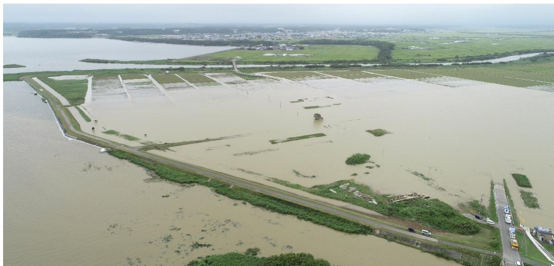
8月16日 午前10時 【入沼排水機場の上空より撮影】
