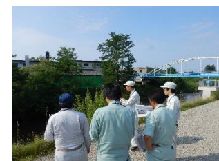
重要水防箇所合同巡視(堤川)
