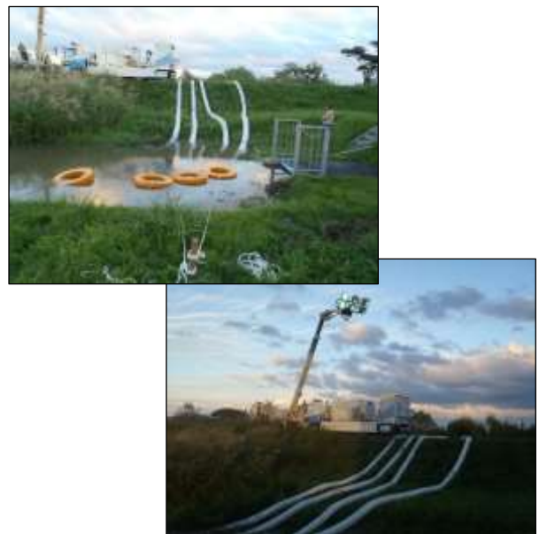
赤川破堤時の排水活動（東北町 H28 台風第9号）
