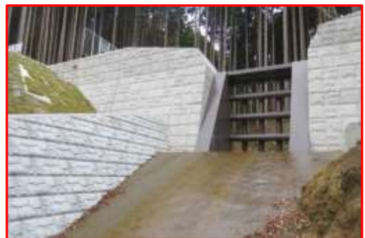
透過型砂防堰堤
