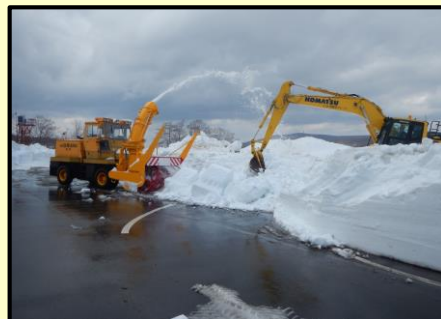
R3.4月 駒込ダム工事現場除雪状況
