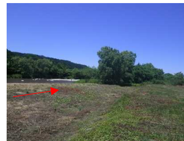
(雑木伐採状況)
