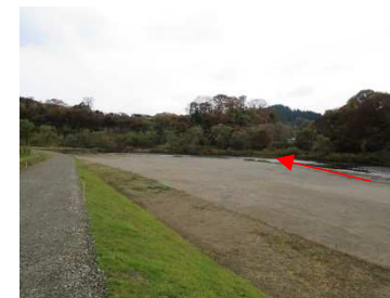
(河床掘削状況)
