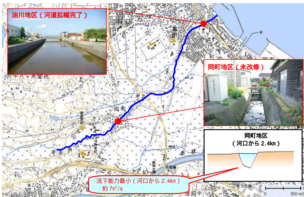
図 1-6 現在の河道の状況
