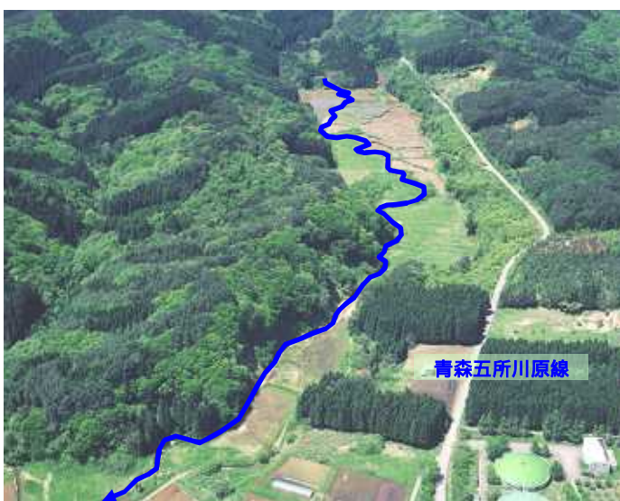
指定区間上流部 (河口より 6.0km 付近)
