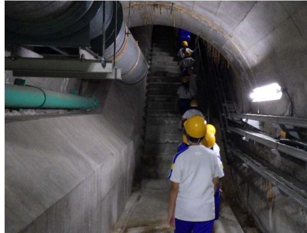
ダム見学 (下湯ダム：監査廊)
