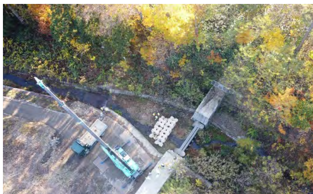
仮設堰堤工造成状況（コンクリートブロック据付完了）
