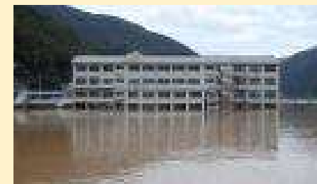
H26.8避難所2階の浸水（徳島県）
