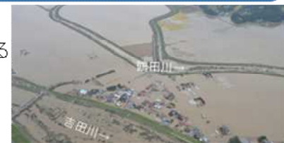
令和元年東日本台風による浸水状況
