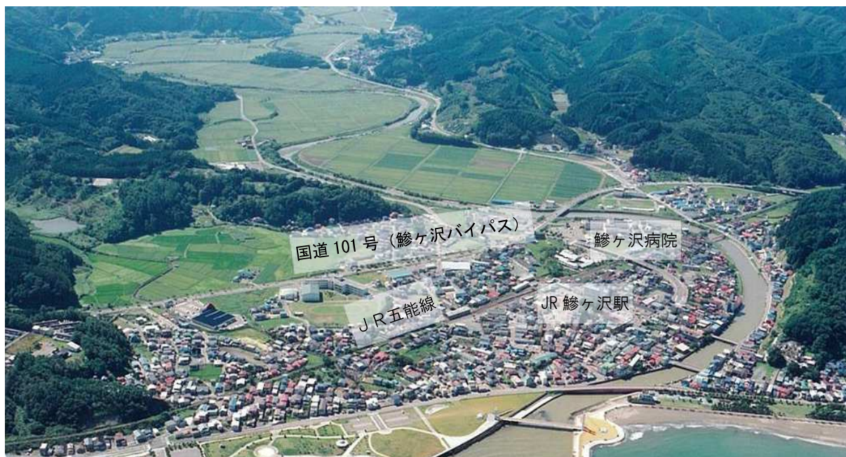
写真 1-1 河口付近の状況
