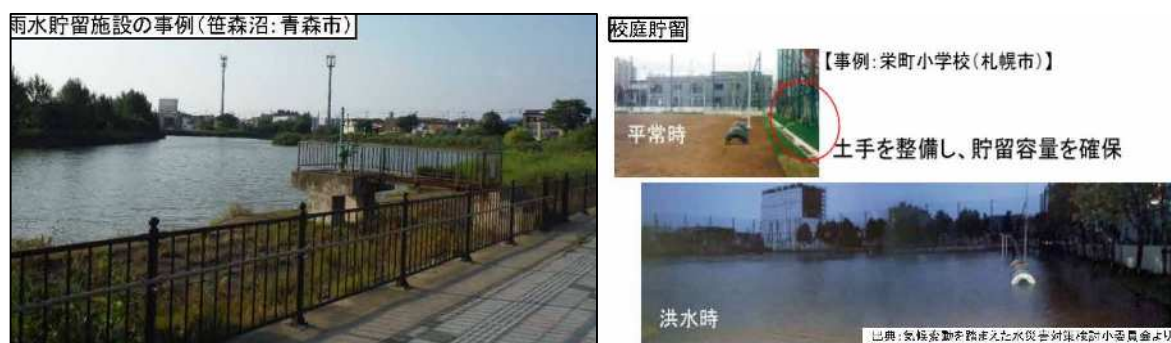
図 7-1 雨水貯留浸透施設の例
