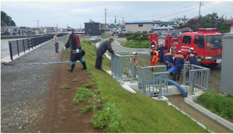
可搬式ポンプによる排水状況
