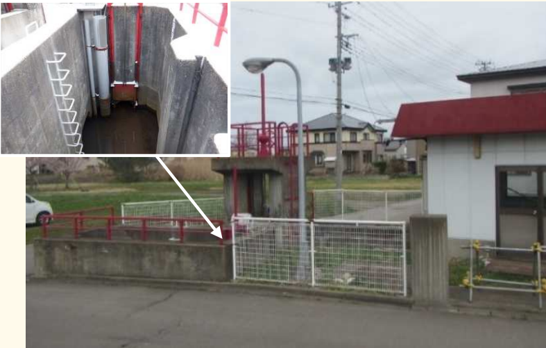
既存の排水機場
