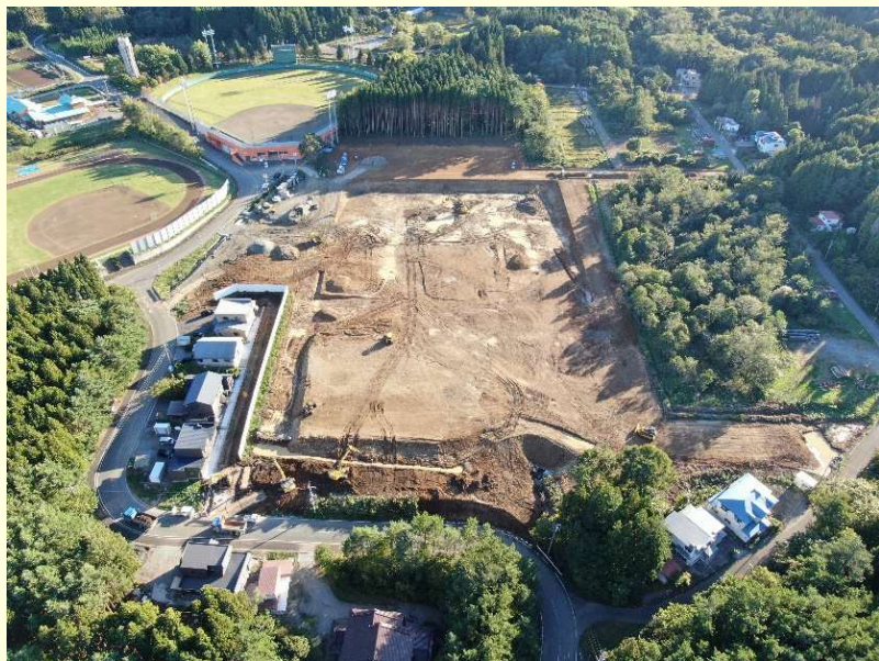
移転場所の造成工事
