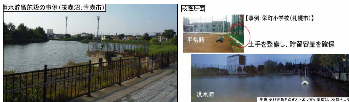
図 7-1 雨水貯留浸透施設の例
