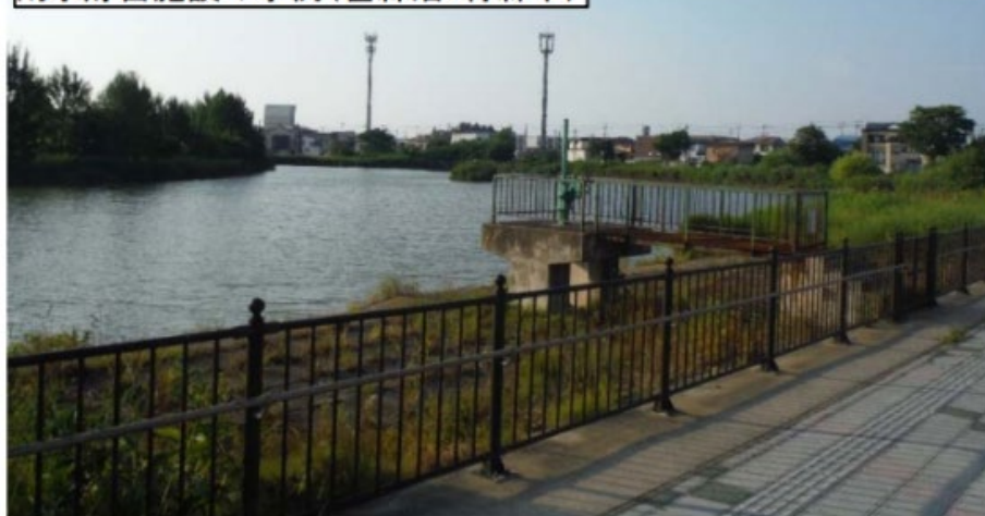
雨水貯留施設の事例(笹森沼:青森市)
