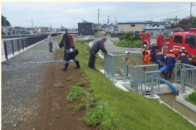
可搬式ポンプによる排水状況
