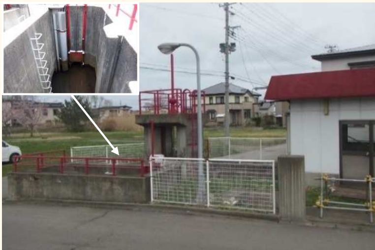
既存の排水機場
