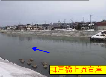
令和7年度 護岸整備状況
