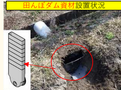
田んぼダム資材設置状況
