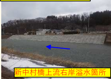
令和7年度 護岸整備状況
