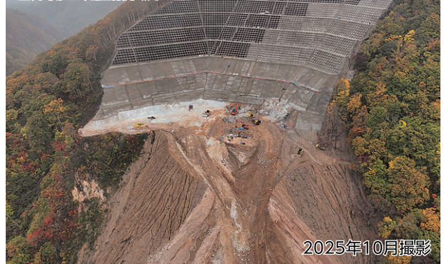
右岸側基礎掘削状況
