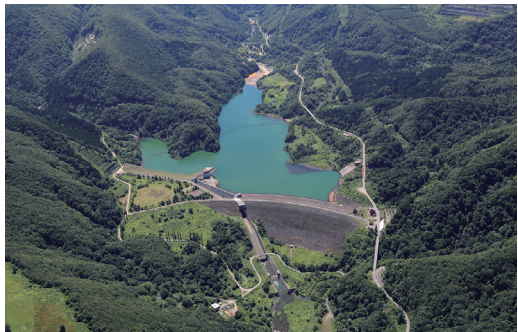
▲下湯ダム（昭和63年度完成） 下湯ダムは、堤川の洪水調節、水道用水の確保及び河川環境の保全を目的として建設されました。昭和46年度に建設に着手し、昭和63年度に完成した貯水容量1,260万㎡のロックフィルダムです。
