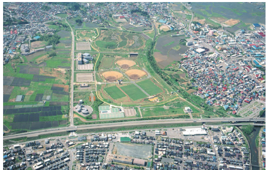
▲横内川多目的遊水池（平成15年度完成） 横内川多目的遊水池は、洪水時に横内川と合子沢川合流後の流量を安全に横内川及び堤川に流下させるために、一時貯留を行う洪水調節施設です。昭和59年度に建設に着手し、平成15年度に完成しました。貯水容量は220万㎡であり、普段はレクリエーション施設としても親しまれている多目的遊水池です。
