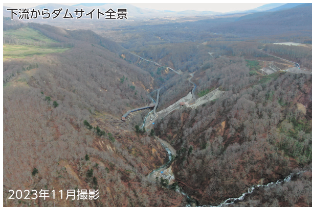
堤外仮排水トンネル吐口完成写真
