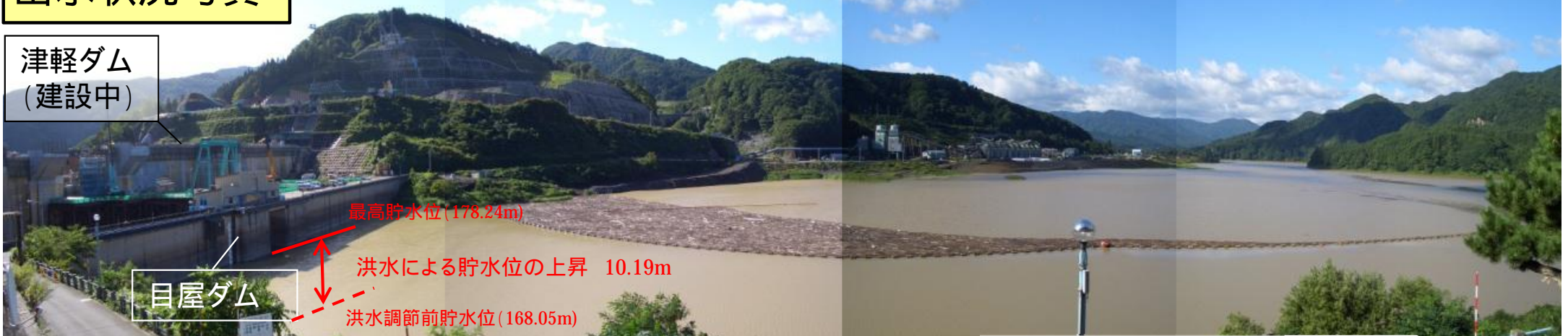
目屋ダム貯水池状況(9月17日9:00 最高貯水位178.24m)
