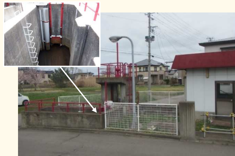
中村川排水機場（既設）
