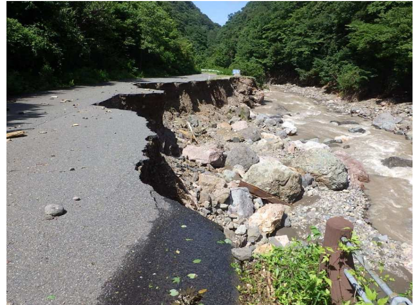
岩崎西目屋弘前線 (深浦町)
