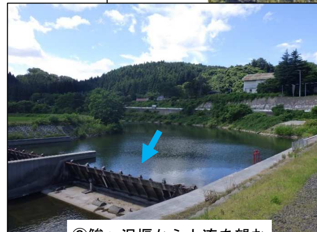
③鰻ヶ沢堰から上流を望む
