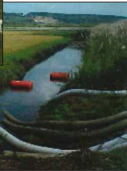
二ツ森橋下流での排水活動(東北町 H18出水)
