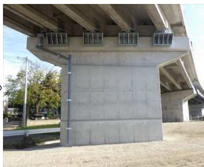
▲国道 280 号 西滝大橋 耐震補強の例
