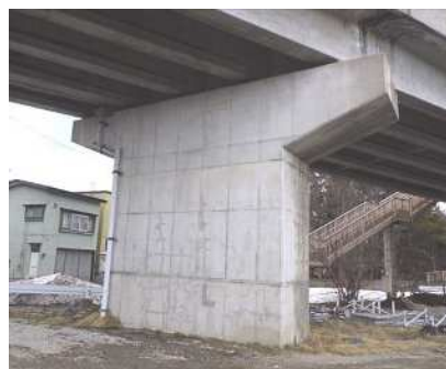
▲国道 280 号 西滝大橋 耐震補強の例
