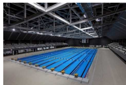
竣工した新水泳場
