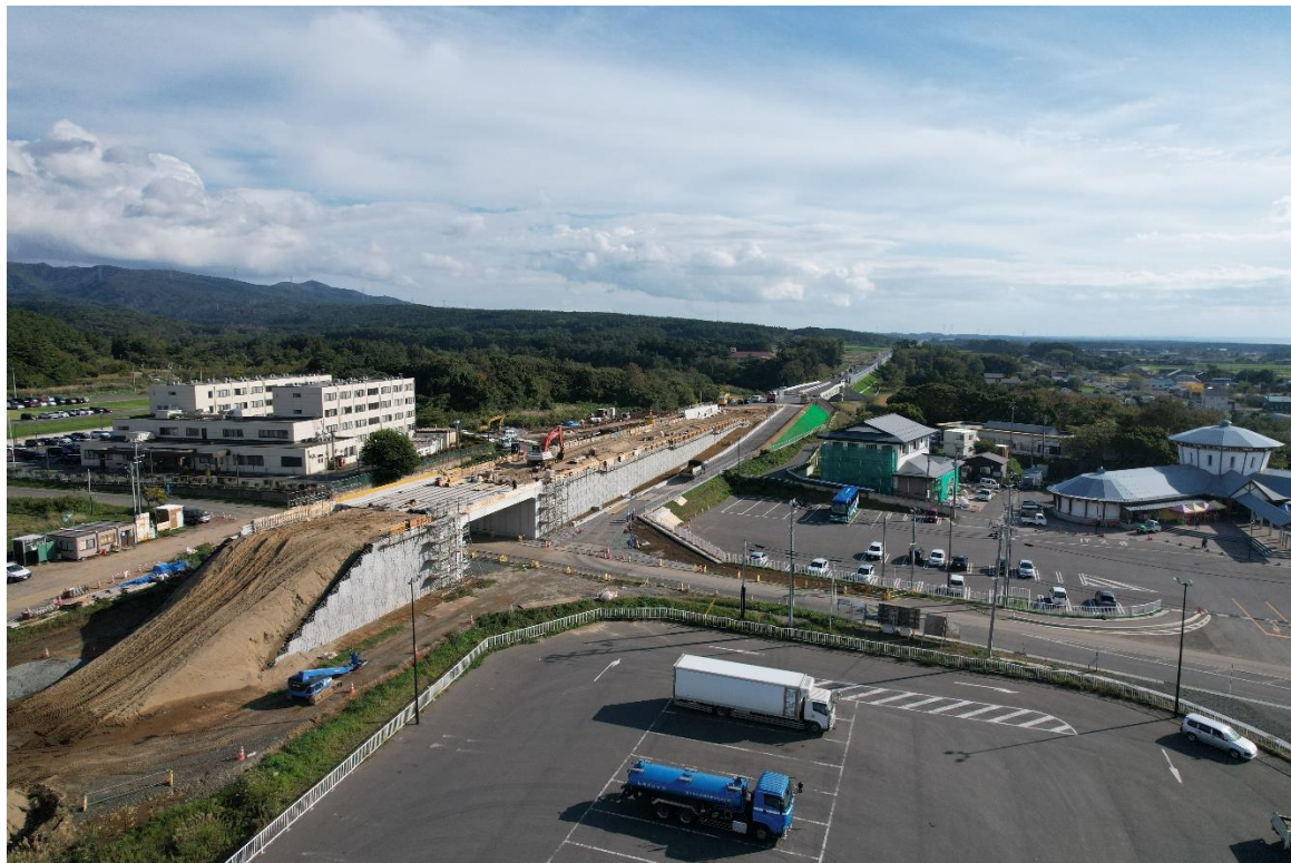
建設中の下北半島縦貫道路（横浜町）
