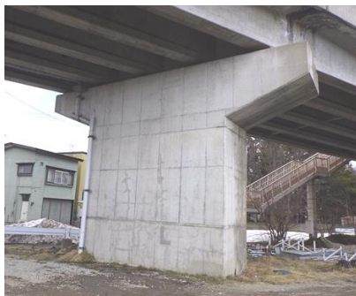
▲国道 280 号 西滝大橋 耐震補強の例
