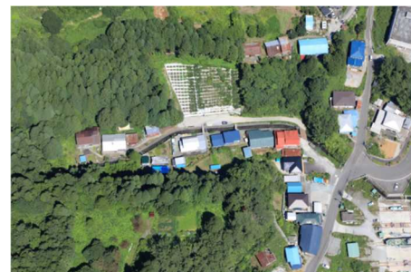
白糠 4 号区域急傾斜地
