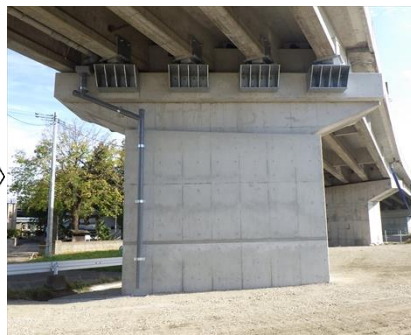
▲国道 280 号 西滝大橋 耐震補強の例
