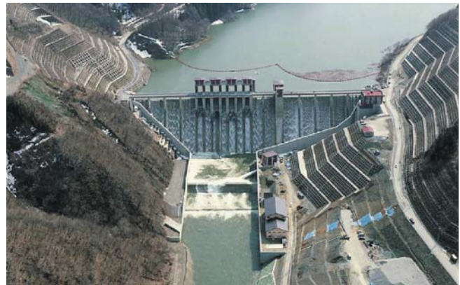
●世増ダム（平成 15 年度完成）
