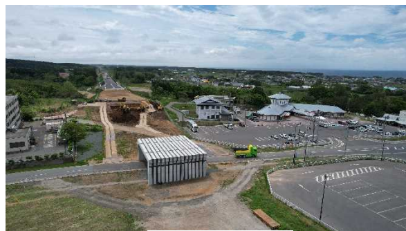
下北半島縦貫道路
