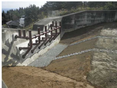
中六ヶ所沢砂防堰堤
