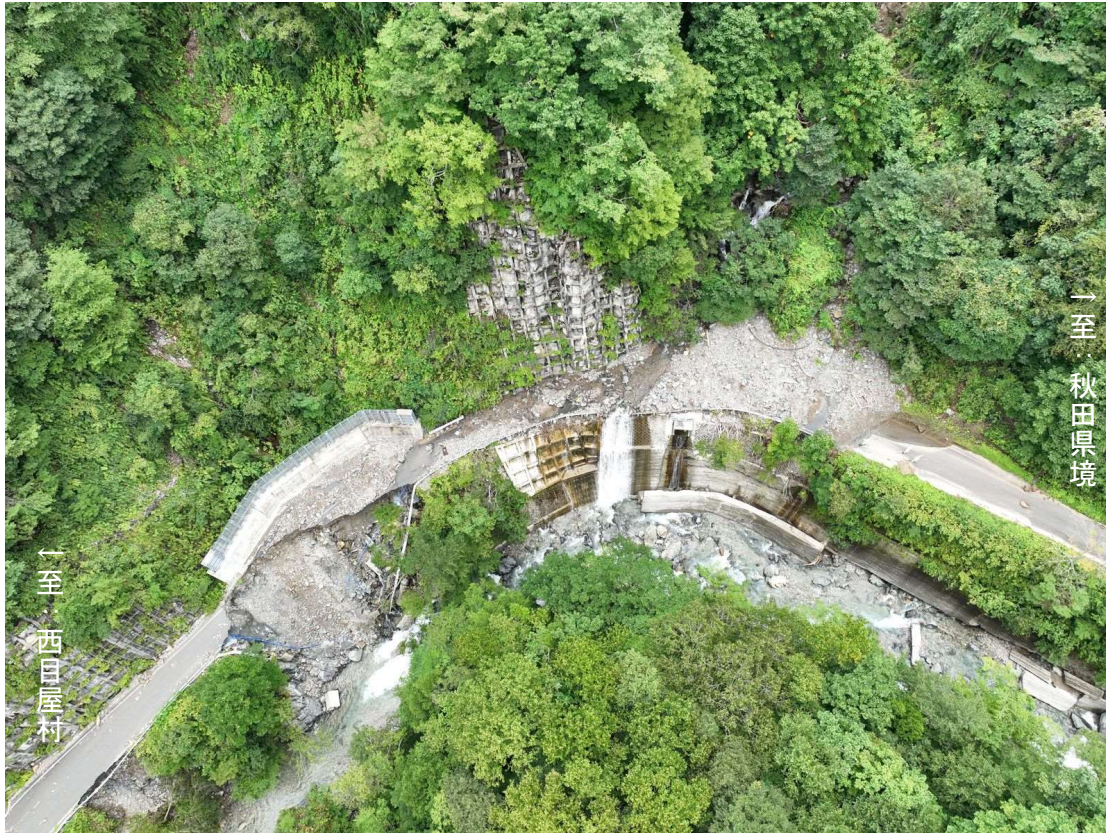
△被災箇所上空全景（令和4年9月撮影）
