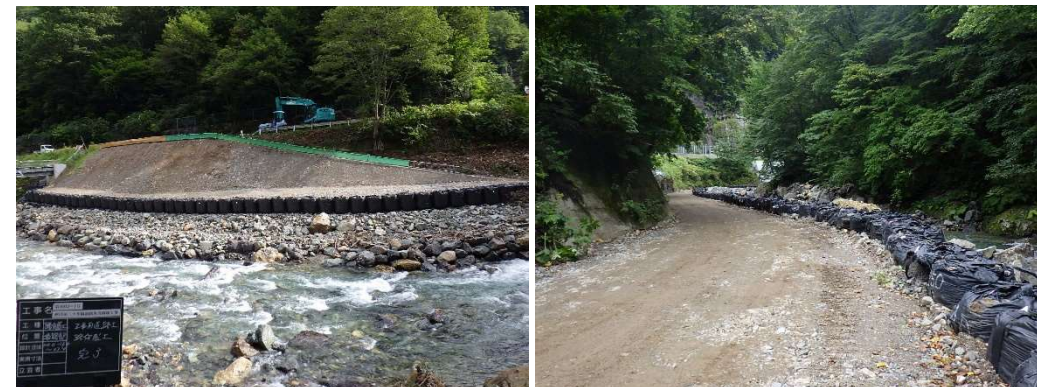
△工事用道路施工状況（令和7年9月撮影）
