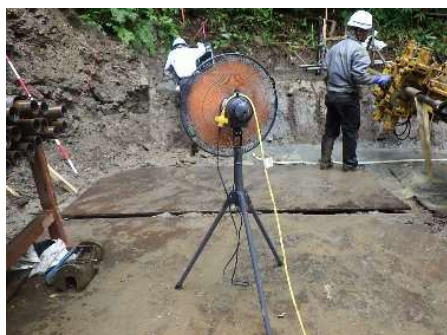
大型扇風機を現場内に設置
