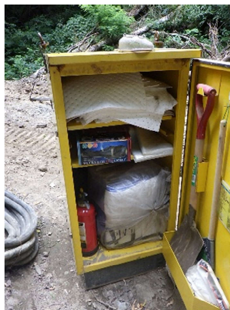
油流出防止対策用品の設置
