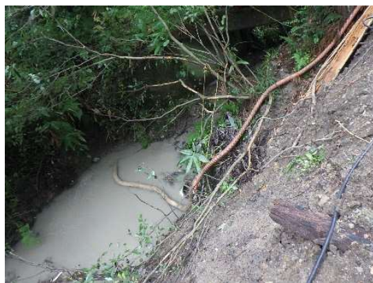
汚濁防止対策用沈殿槽の設置
