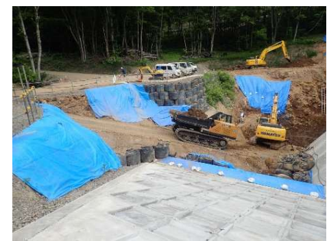
不整地運搬車による土砂運搬
