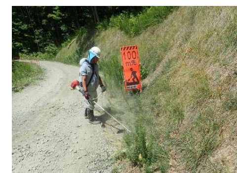
工事用道路の草刈り
