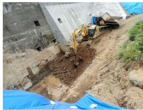
バックホウによる掘削・積込
