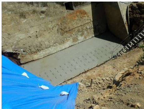
均しコンクリート打設
