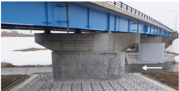
橋梁補修（耐震補強）事業 （弘前柏線・弘前市三和【三和大橋】：令和7年3月完成）
