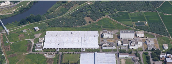
岩木川浄化センター
