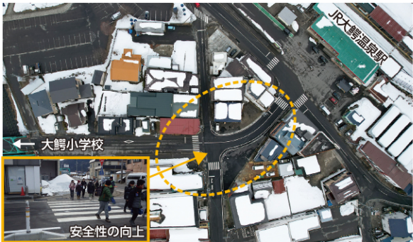
交通安全事業（交差点改良） （碓ヶ関大鰐停車場線・大鰐町大鰐：令和7年3月完成）
