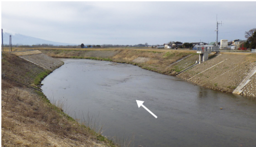
平川広域河川改修事業（弘座川工区）
