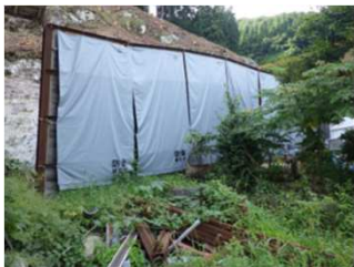
【防音シート貼付状況】
