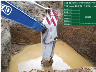
湧水箇所での地盤改良施工状況
