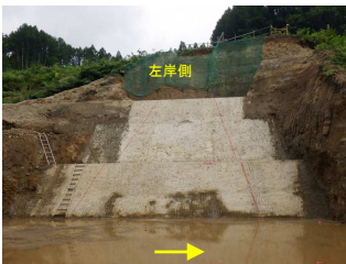
地盤改良工完了全景
