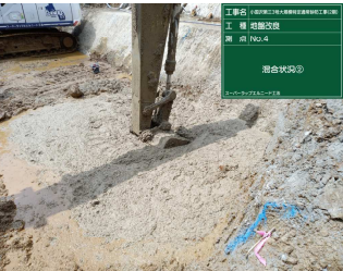
湧水箇所での地盤改良施工状況
