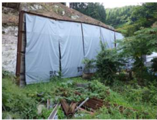
【防音シート貼付状況】
