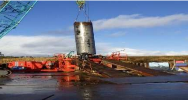
【 RC橋脚工 場所打ち杭工】
