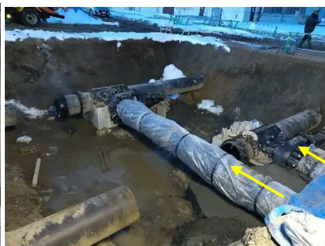
切り廻し作業完了 (不断水分岐工完了)
