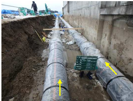
管布設工完了 (埋戻し前)
