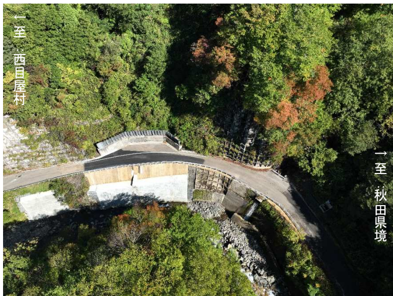
完成箇所上空全景（令和8年10月撮影）
